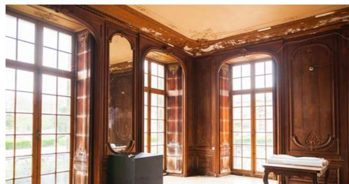
Les pièces, aux huisseries abimées et aux murs et sols dégradés, souffrent d'une humidité structurelle, avec la présence de moisissures et même de la mэрule, un problème qui est en cours de traitement.
